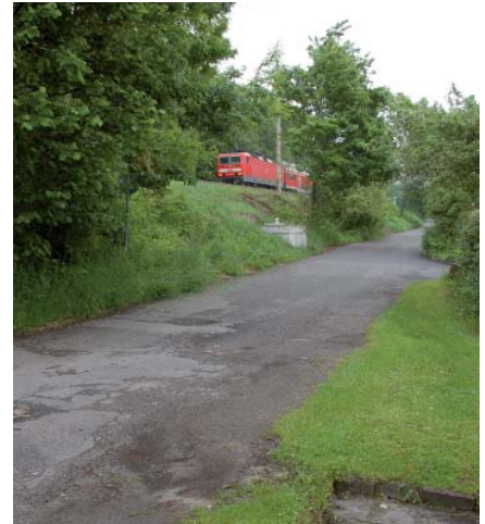
Der Bau der Flutungspolder wurde auch deshalb ausgesetzt, weil es noch keine Lösung für die Sicherung der Bahnstrecke am Rande der Neuzeller Niederung gibt.
